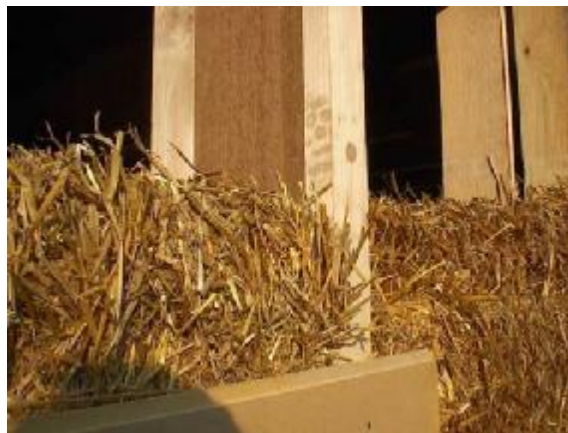
Plattenbekleidete Strohballenausfachung
