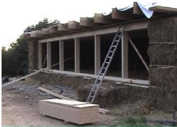
Lasttragender Bau mit Großballen
