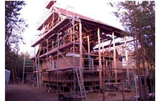
Rundholzbau mit Strohballen ohne Maschineneinsatz
