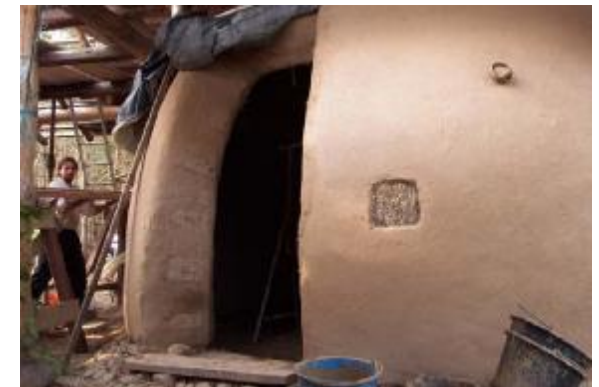
Selbsttragende Strohballenkuppel ø Innen ca. 3,90m
