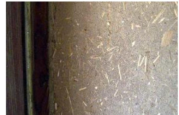
Lehmputz mit hohem Strohanteil
