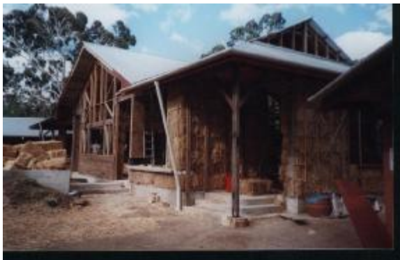
Frank Thomas Strohballenbau
