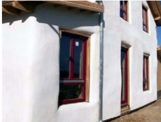
Kalkputz als wetterfeste Aussenbekleidung
