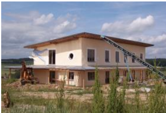
Haus Warmuth: Strohballen aussen davor, m. Kalkputz
