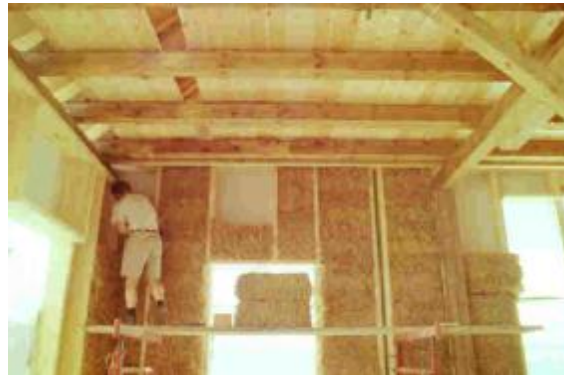
Scheunenumbau mit Strohballen- Innendämmung
