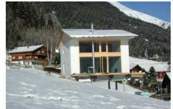
Lasttragendes Strohhaus mit Großballen
